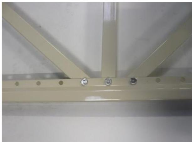
Mettre les boulons sur la deuxième traverse et diagonale (ne pas serrer).
