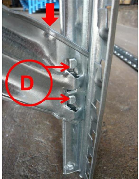
Taper avec le maillet au niveau de la flèche rouge pour enfoncer la diagonale jusqu'à ce que les plots du montant soient en butés dans l'encoche de la diagonale
