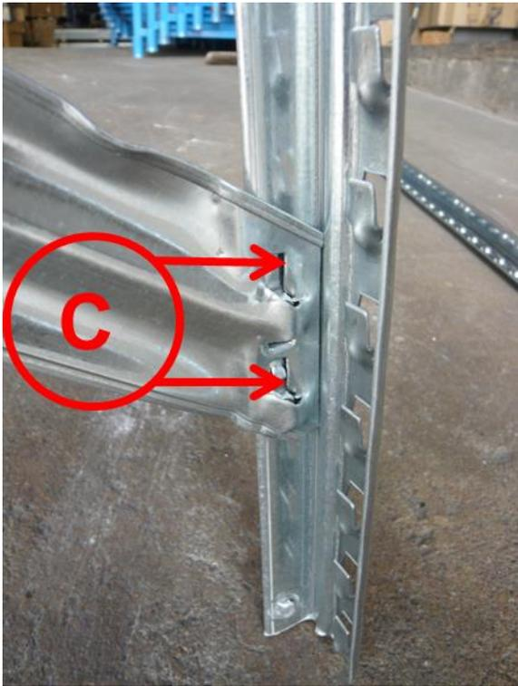
Positionner les encoches de la diagonale dans les plots du montant
